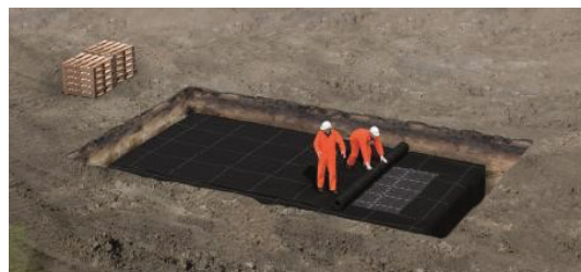
Obrázek 13: Zakrytí geotextilií
